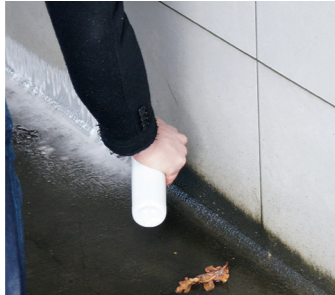
bioTop clean wird auf Grünbeläge am Übergang zur gefliesten Wand aufgetragen.
